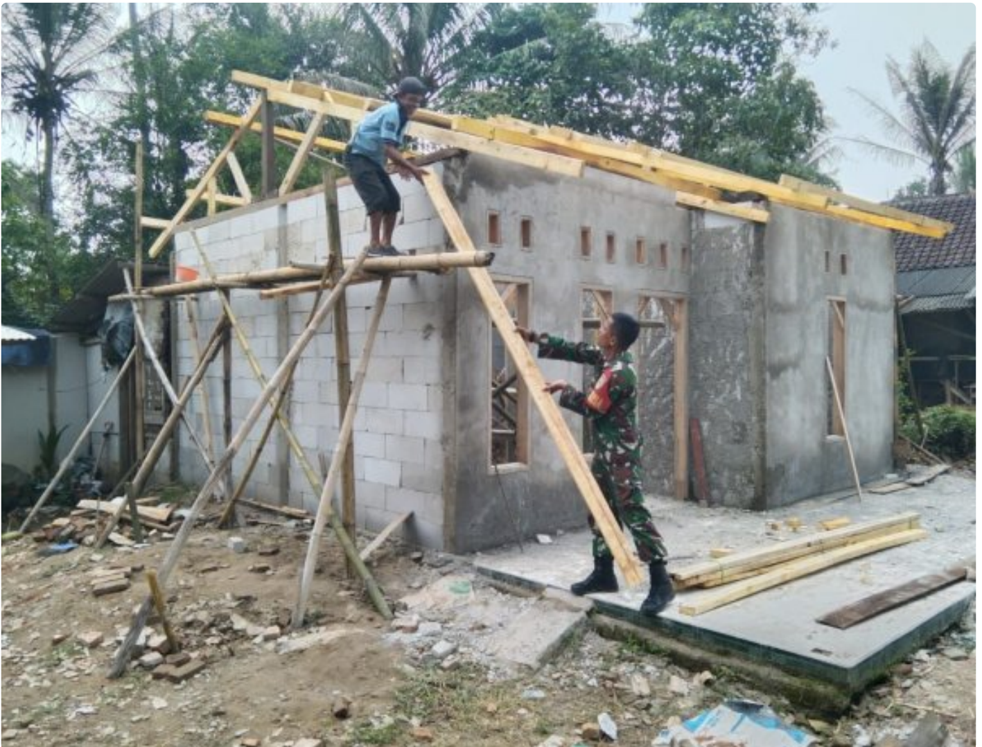
Serda Naya membantu pemasangan atap RTLH
